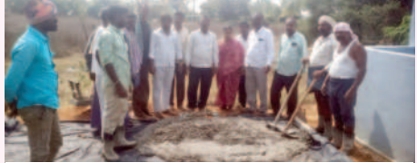
సీసీ రోడ్డు పనులను ప్రారంభిస్తున్న చహూదతీ సభ్యురాలు అంజయ్యగౌడ్
